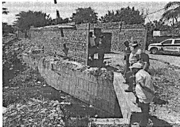
Imágenes N°3. Apertura de la visita, colector del centro histórico de Valledupar. Fuentes Propias
