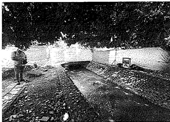
**Ilustración 3. Punto de final de canal a construir en concreto reforzado para reemplazar canal en ciclópeo existente, Coord. 73°16'41.33"O - 9°42'16.32"N.**
