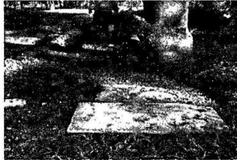
Figura 8. Caja de inspección de conducción de aguas tratadas, para la toma de muestras cuando no hay accesibilidad al punto de descarga sobre el río Cáchira. Punto fuera de ronda
