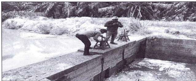
Imagen 5. Evidencia fotográfica compuertas de acceso del agua para las empresas LCM, RC&H y La PAULINA.
