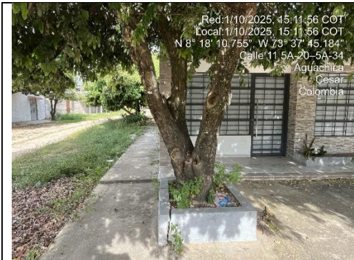
IMAGEN 1-Daños fitosanitarios del primer árbol y afectación a la jardinera. FOTO. autor
