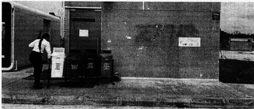
Imagen 14. Vista general zona de baños. Fuente: Propia
