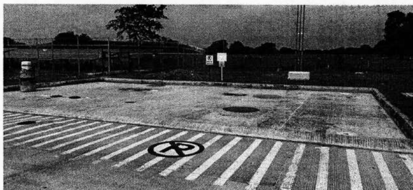
Imagen 6. Vista general área tanques de almacenamiento de combustible. Fuente: Propia
