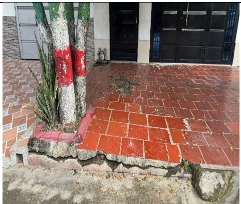
IMAGEN 2-Daños causados a las losas de la vivienda. FOTO. autor
