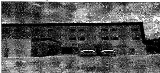
Figura 6. Zona de carga y descarga.
