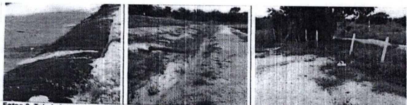
Fotos 8. Talud sin geomembrana, canales perimetrales enmalezados y rotos de entrada en el encerramiento del área del sistema lagunar.
