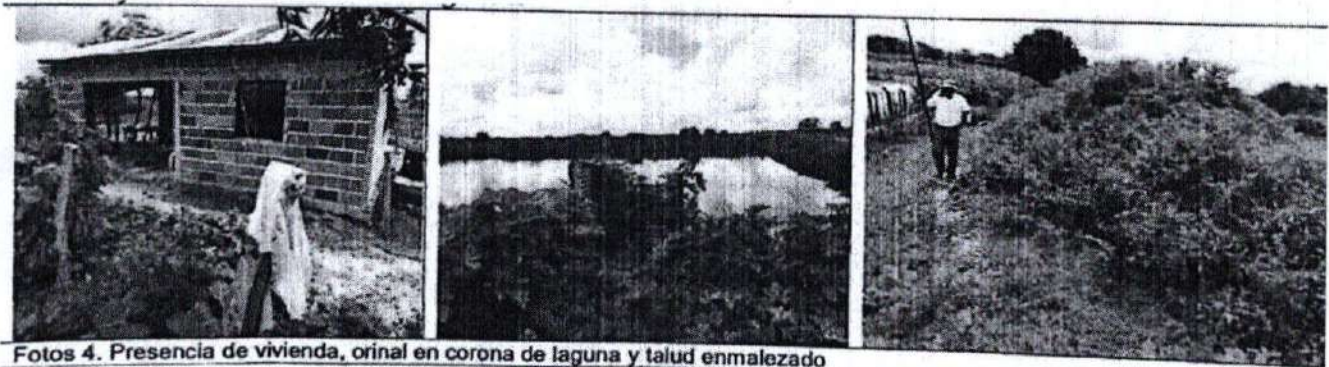
Fotos 4. Presencia de vivienda, orinal en corona de laguna y talud enmalezado
