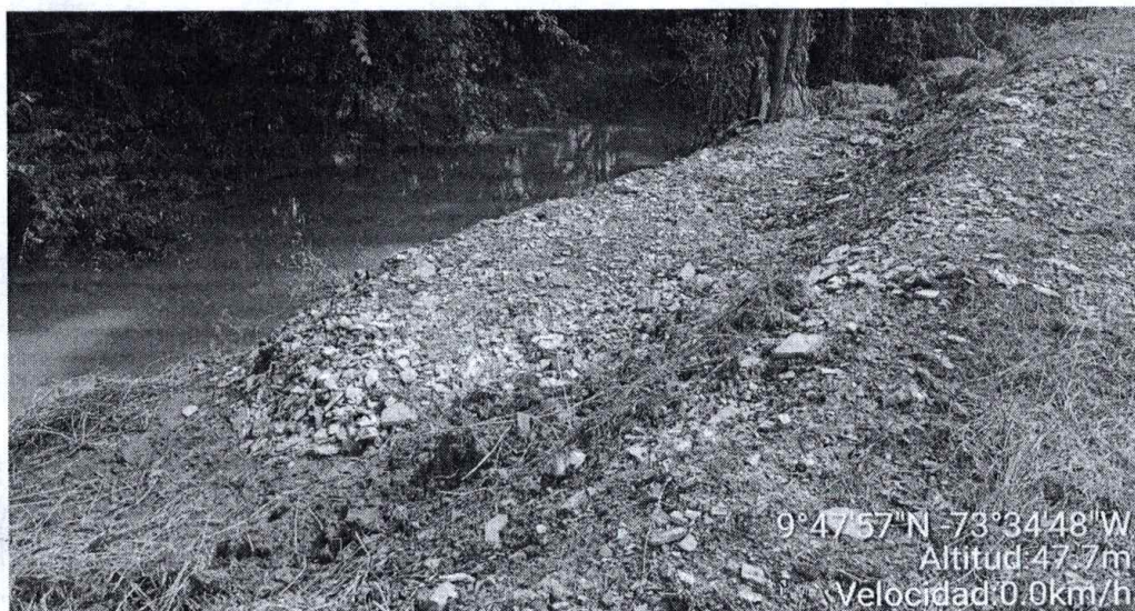
Imagen 7. Visualización de Residuos RCD en terraplén
