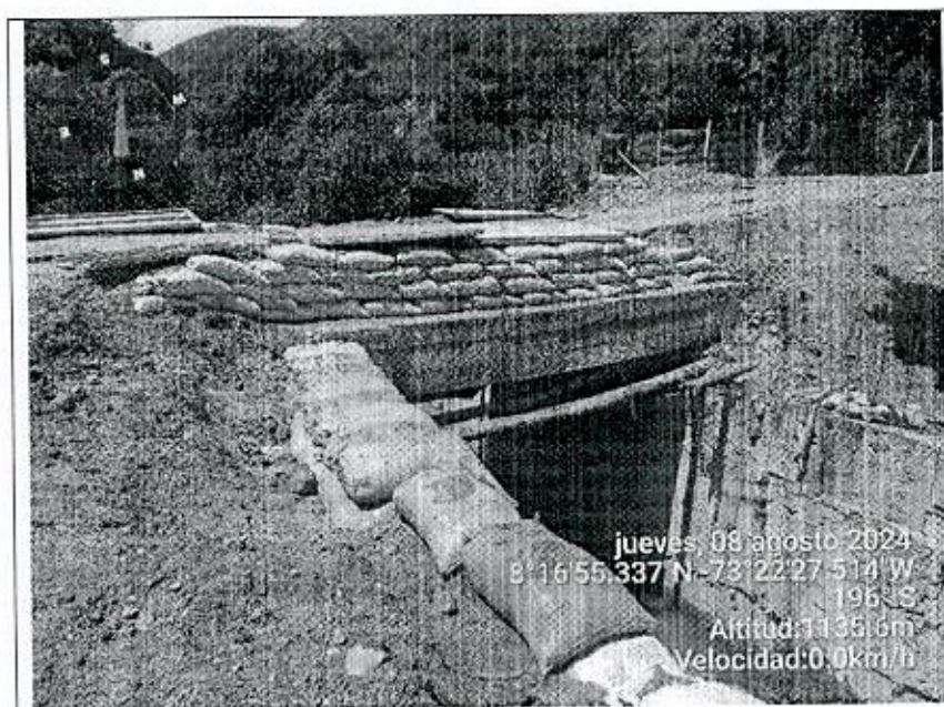
Imagen 2. Vista lateral del puente y muros en concreto e instalación de costales rellenos de material.
