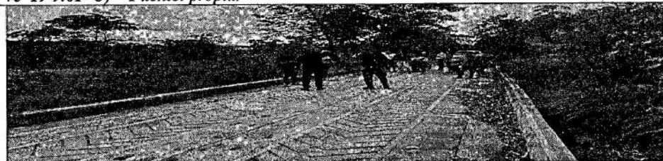
Figura 11. Drenaje menor de escorrentía K3+949.86 – Alcantarilla sencilla 36" (Coord. Geog. Ref. 9°27'46.20"N 73°18'54.73"O) – Fuente: propia.
