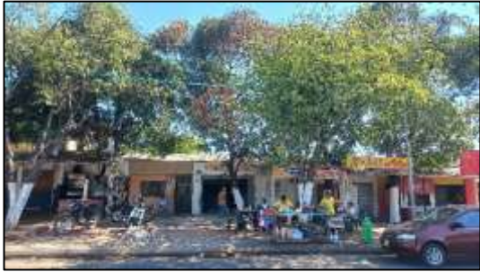
Fig 2. Vista general del estado actual.
