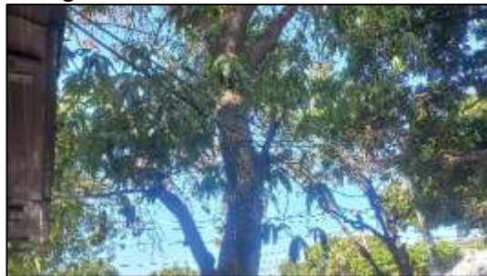
Fig.8 Contacto con redes eléctricas.
