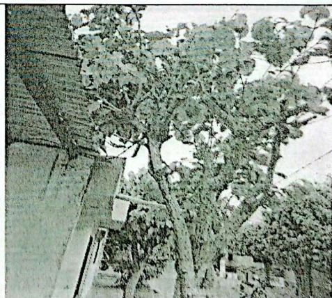
IMAGEN. Ubicación del árbol de la especie " Coccoloba lehmannii- Lindau ", o maíz tostado, ocasionando daños al techo de la vivienda. FOTO. autor
