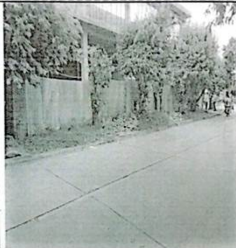
IMAGEN 1-Facha de la construcción.
