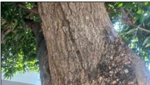
Fig. 6 Estado de la corteza por comején.
