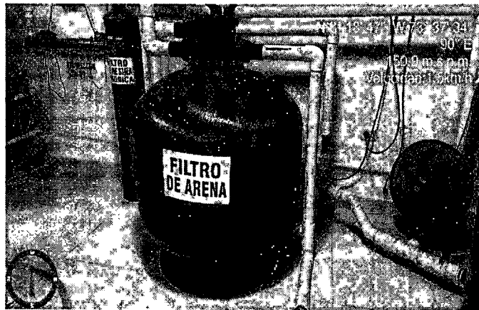
6. Filtro de resina aniónica, para control de nitratos.
