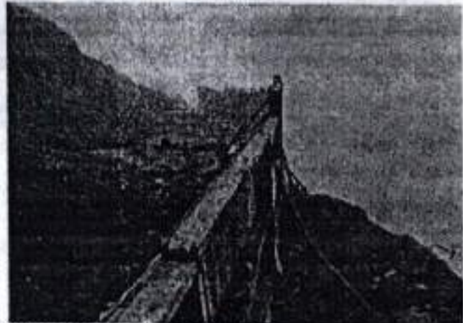
Fotos 32 y 33. Formaletas de madera para retención de material en la excavación para la vía
