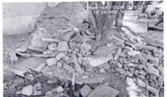
Imagen 4. Construcción que se está llevando a cabo. Fuente: Autor 2026.
