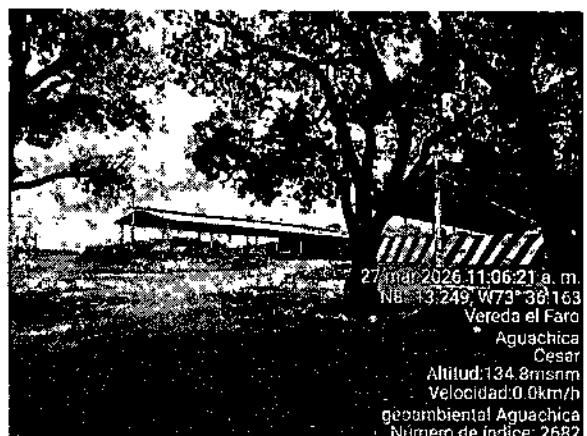
Foto5. Infraestructura de hangar
