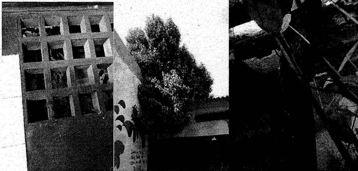
Imágenes 26, 27 y 28: Árbol creciendo en un espacio entre las paredes del baño de hombres en las instalaciones del colegio.
